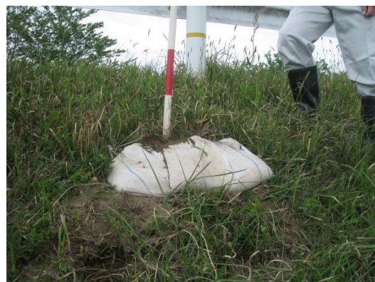
点検で見つかった法勝寺川堤防の小穴を速やかに補修実施
