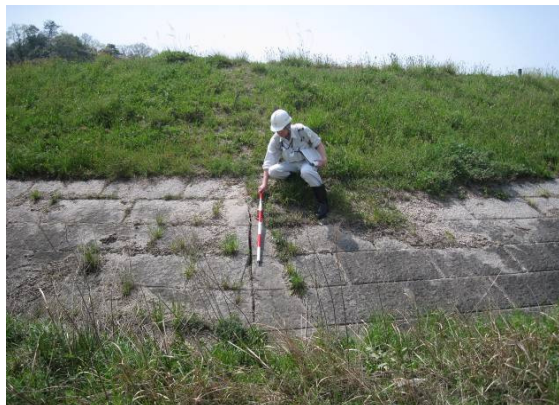
護岸の点検状況
