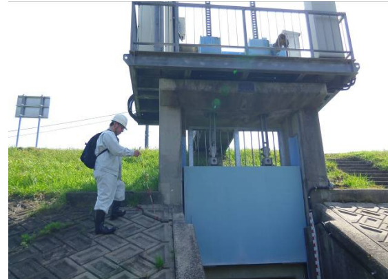
樋門の点検状況
