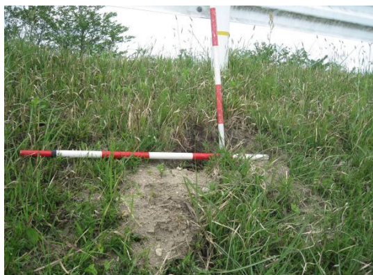
点検で見つかった法勝寺川堤防の小穴を速やかに補修実施
