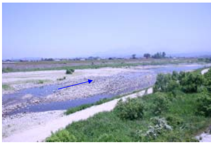
米子市八幡箇所(八幡橋下流) (水量が少なくなっているため、水深が浅くなっている)
