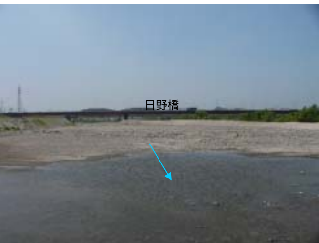
米子市吉岡箇所 (上流からの水の供給がなく、水たまりとなっている)
