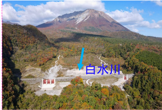
完成(側壁、鋼製スリット)
