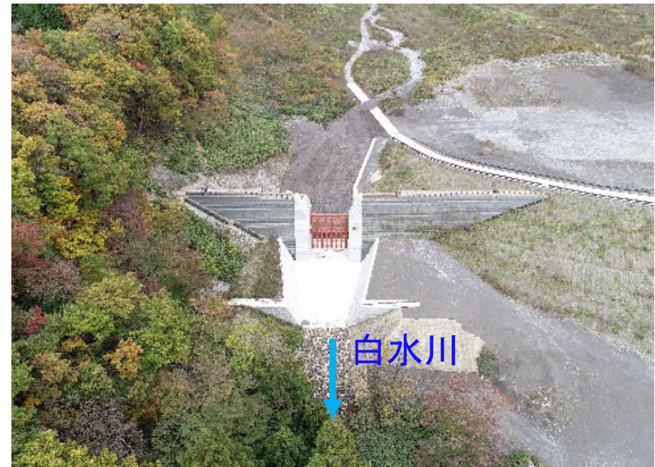
完成(側壁、鋼製スリット)
