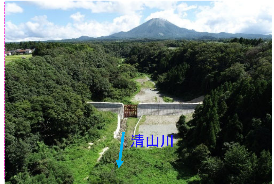
完成(側壁工、鋼製スリット)
