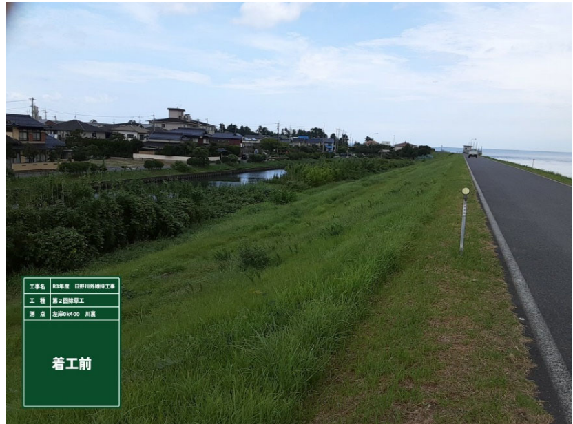
堤防除草着手前(米子市皆生新田地区)
