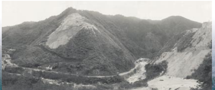
掘削が始まったダム地点(日南町菅沢 宮本宏己氏提供)
