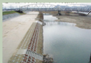
施工後(平成14年3月撮影)
