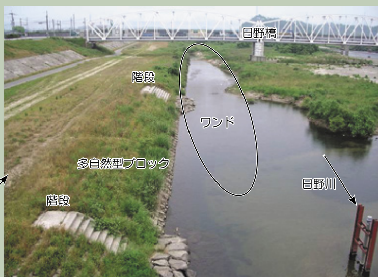
現在の吉岡護岸(平成18年6月撮影)
