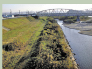
施工前(平成12年11月撮影)
