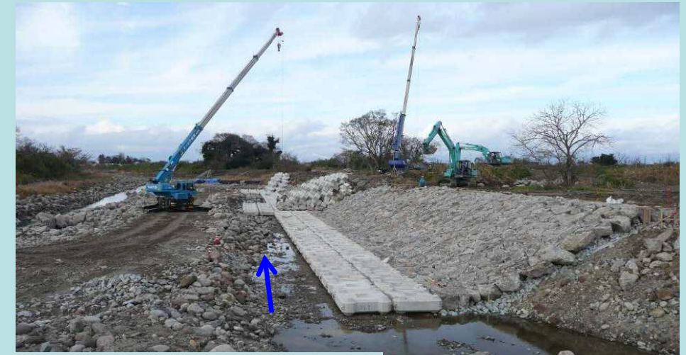
巨石張り工・根固めブロック工
