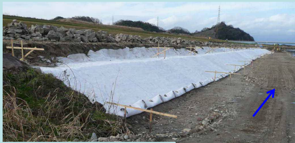
巨石張り工(吸い出し防止材設置)
