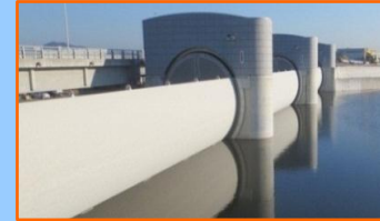
平成水門 (百間川河口水門)
