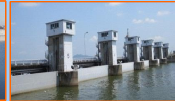
昭和水門 (百間川河口水門)
