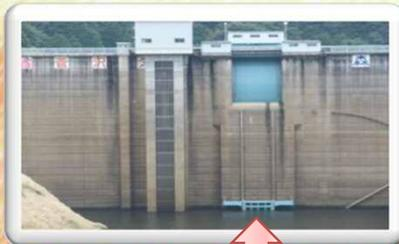
予備ゲートを下げ、その後、放流管の中の水を抜き主ゲートや放流管の点検を実施します。
