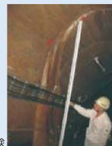
ダム内部の点検
