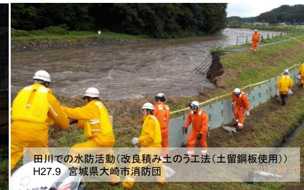
2015. 09. 10 田川での水防活動（改良積み土のう工法（土留鋼板使用））
