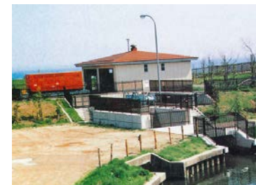
皆生排水機場(H8年度完成)
