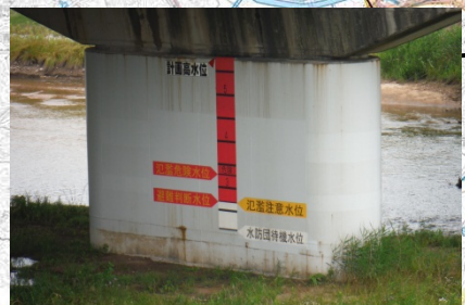
法勝寺川 安養寺橋(米子市)
