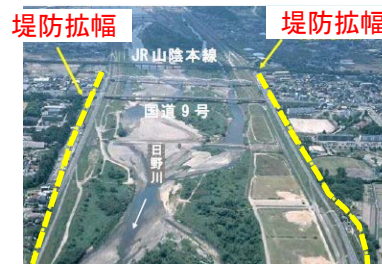
車尾地区堤防拡幅後 (H18撮影)
