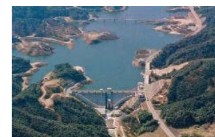
賀祥ダム(県管理)
