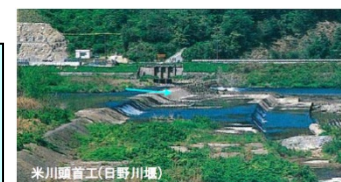
日野川改修前
