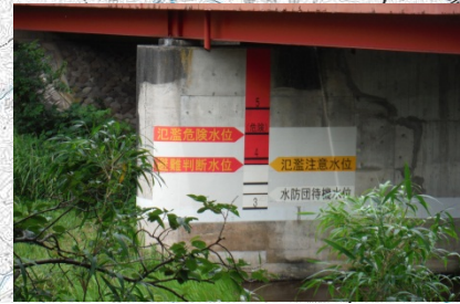
法勝寺川 宮の前橋(南部町)
