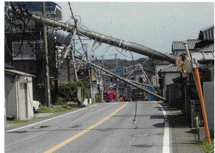
電柱倒壊 館山市船形
