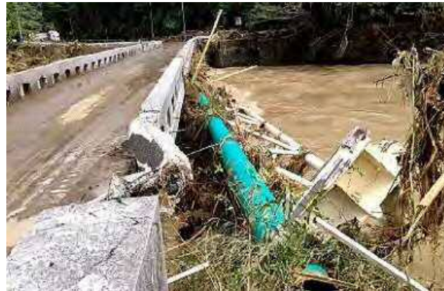
水管橋の損壊（興津川・宮嶋橋）
