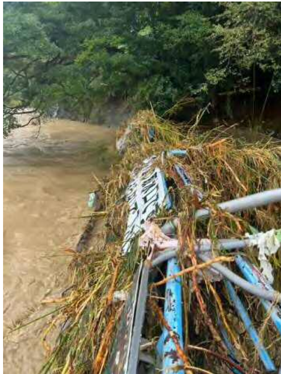
承元寺取水口の様子（興津川）
