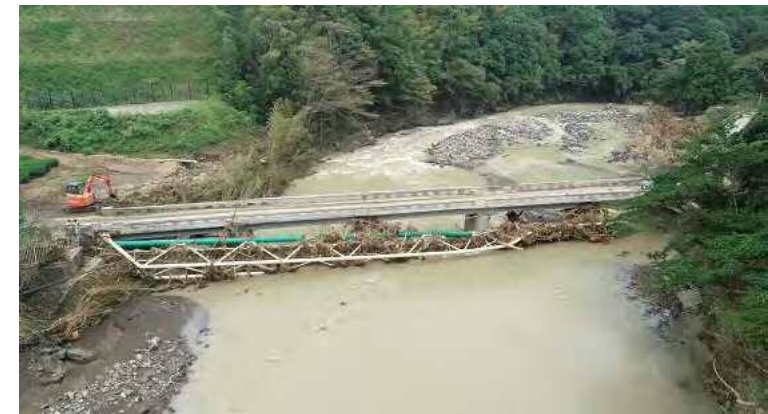
水管橋の損壊（興津川・宮嶋橋）
