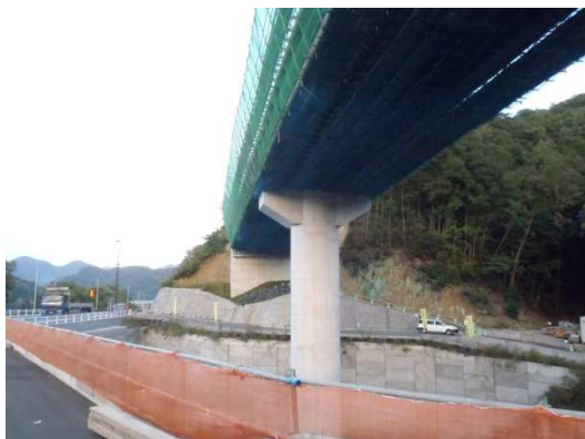
③瀬野高架橋〔広島市安芸区上瀬野町地内〕 【平成27年10月2日撮影】
