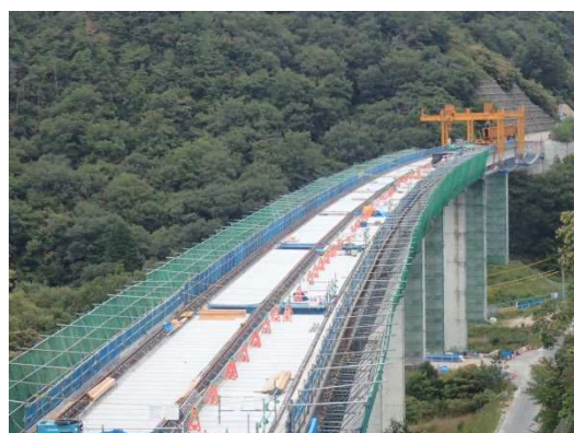
①大山高架橋〔広島市安芸区上瀬野町地内〕 【平成27年9月30日撮影】
