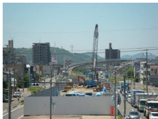
④海田高架橋〔安芸郡海田町曙町地内〕 【平成27年5月19日撮影】
