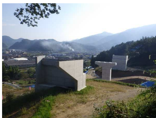
②神原高架橋〔広島市安芸区上瀬野町地内〕 【平成27年10月4日撮影】
