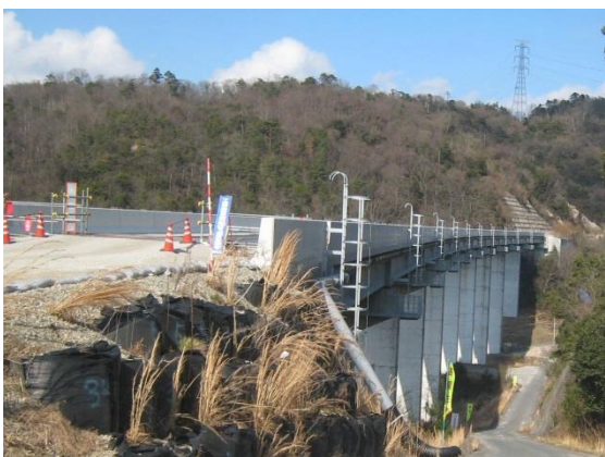
①大山高架橋(広島市安芸区上瀬野町地内) 【平成29年3月7日撮影】※H29.11時点変更なし
