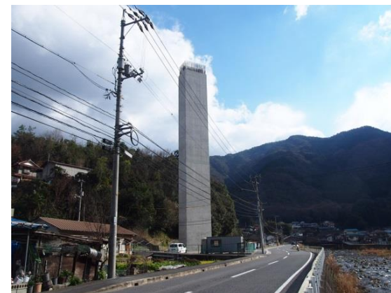
④熊野川高架橋(広島市安芸区上瀬野町地内) 【平成28年1月15日撮影】※H29.11時点変更なし
