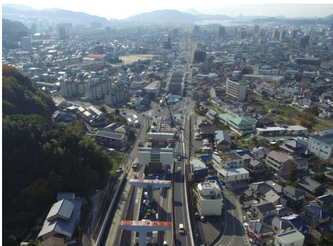
⑤海田高架橋〔安芸郡海田町寺迫から〕 【平成29年11月27日撮影】
