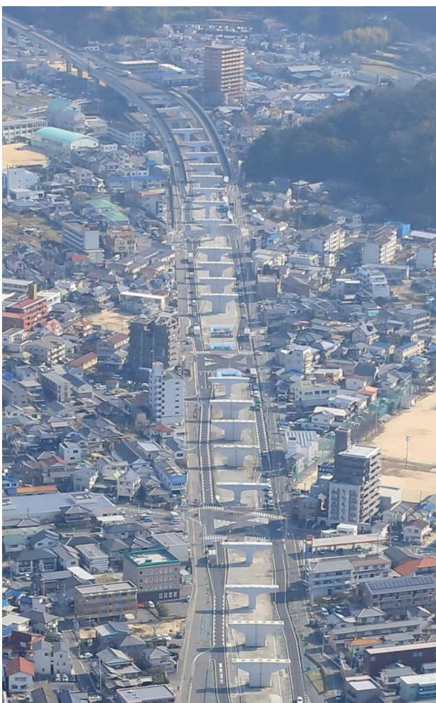
⑥海田高架橋（安芸郡海田町曙町から） 【平成30年3月13日撮影】
