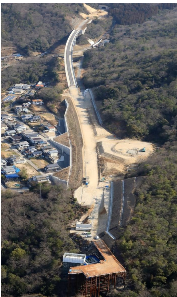
②大山高架橋 付近 (広島市安芸区上瀬野町) 【平成30年3月13日撮影】
