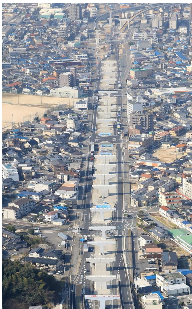
⑤海田高架橋（安芸郡海田町寺迫から） 【平成30年3月13日撮影】
