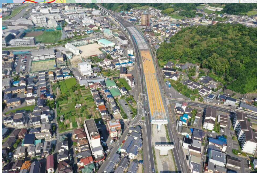
⑤海田高架橋から東広島方面を望む
