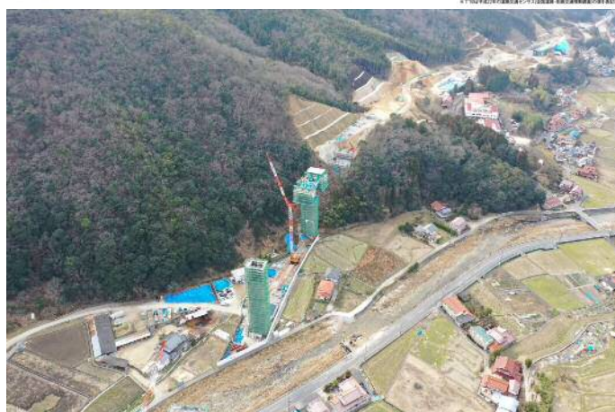
③熊野川高架橋（仮称）から広島方面を望む
