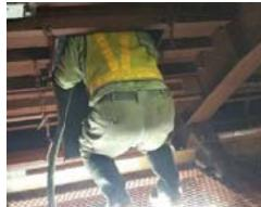
写真1. 検査窓からのバイブルータによる締め固め作業
