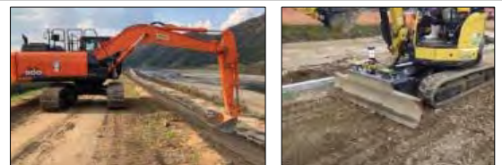
ICT建機による施工
