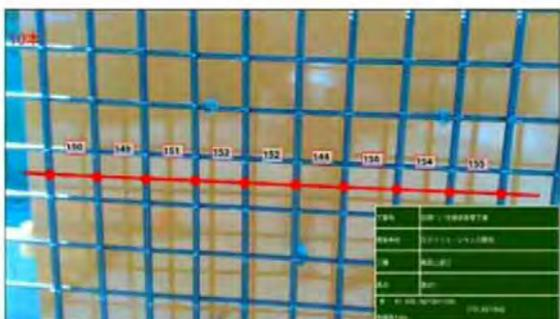
タブレットで撮影した画像から鉄筋を抽出し、鉄筋の本数と鉄筋間の距離を自動計測します。電子黒板の表示にも対応しており、現在現場で撮影されている写真と同じ情報を収めた画像を自動生成できます。
