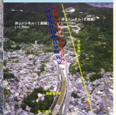
阿賀上空より 休山トンネル東側坑口を望む
