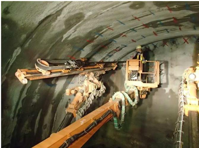
掘削前に長尺の鋼管を打設することで、沈下を抑制する工法を採用しています。
