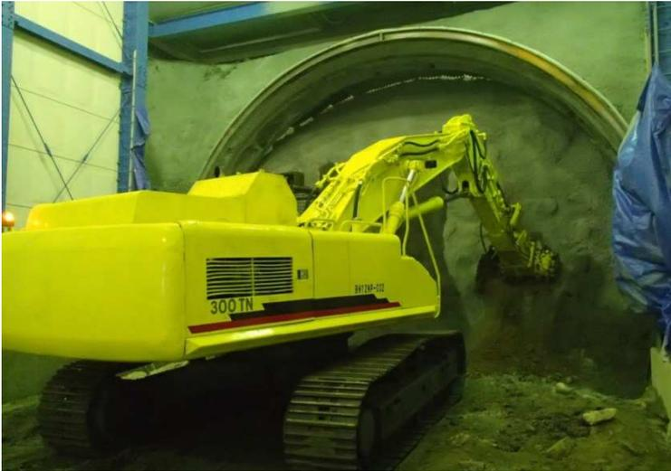
トンネル切削機（ツインヘッダー）で掘削開始
