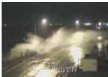
国道2号大野町鴨川の越波状況 9月6日22時～7日2時40分 全面通行止め
