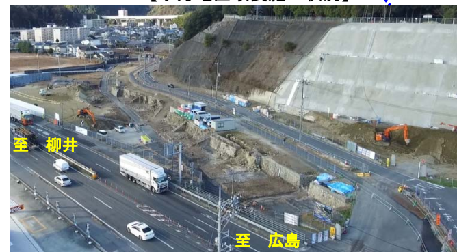
【小方地区改良施工状況】
