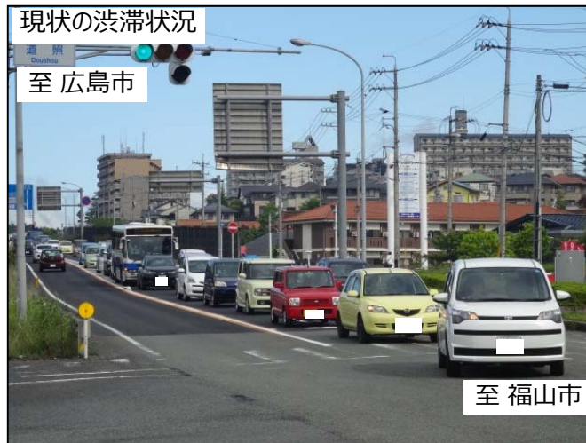
一般国道2号西条バイパス道照交差点
