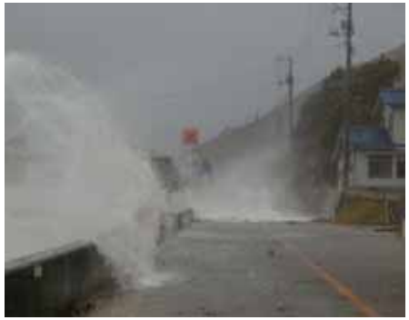
豊田郡安浦町地内 越波状況
