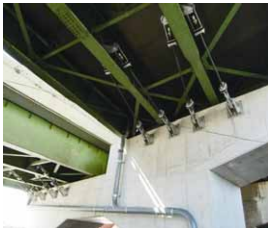
海田高架橋における落橋防止の例
