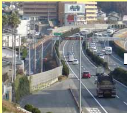
平成16年3月 (施工前)
