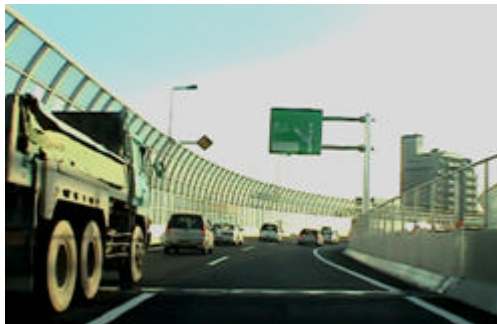
高架道路 (開通後) の通行状況
