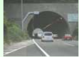
屋代トンネル
