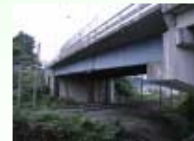
地御前跨線橋
