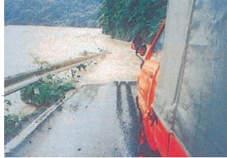
▲ 洪水による路面冠水 (一般国道375号 三次市作木町)
