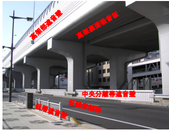
図11-3 都心部延伸における環境対策（西区南観音地区）
