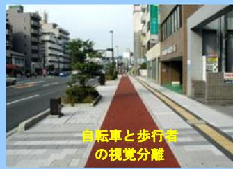
【国道54号の整備例】歩行者と自転車を区分することを目的に、視覚的分離による自転車通行帯を、現況幅員内で整備しました。当該地区の電線共同溝工事に合わせ、歩道的美装化を一体的に行いました。
