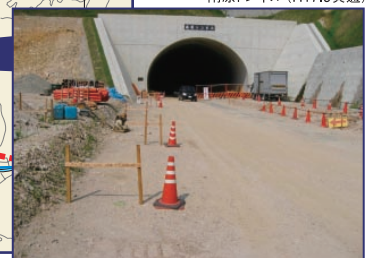
南原トンネル(H17.9貫通)
