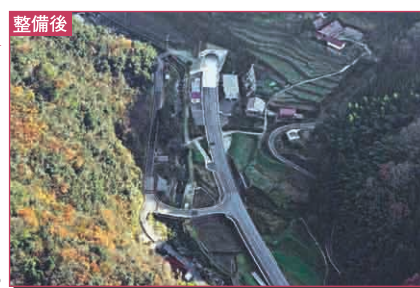
両国トンネル (北西側より撮影)
