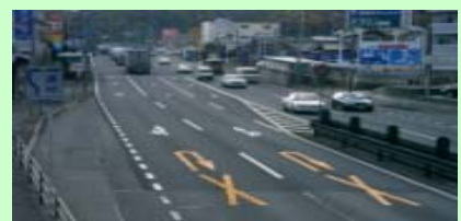
廿日市地御前 (国道2号)
