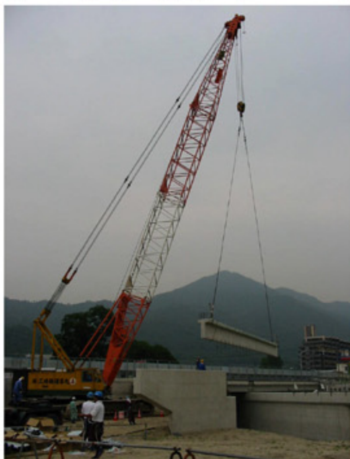
PC桁の架設状況
