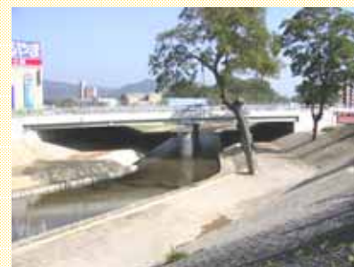
上流側から見た状況です。
