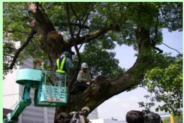
樹勢回復措置状況(H19.7.31)
