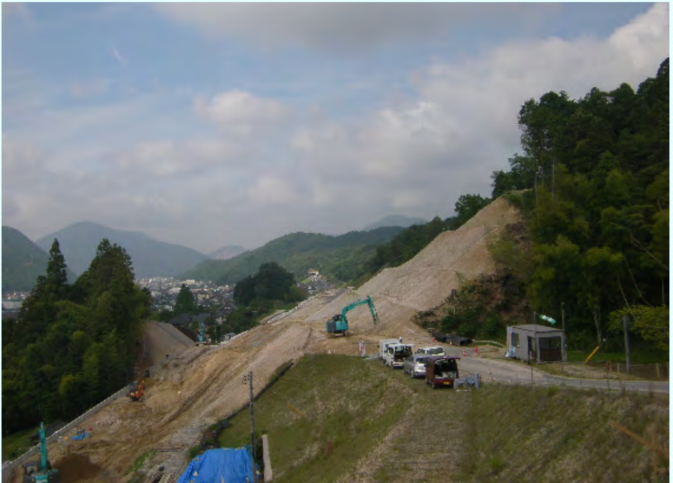
工事現場の様子
