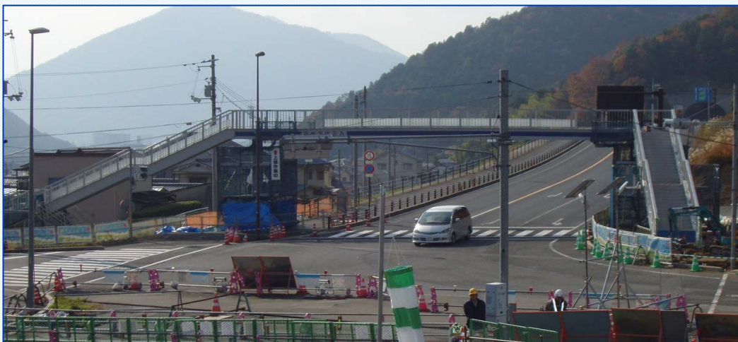
～横断歩道橋全景～
