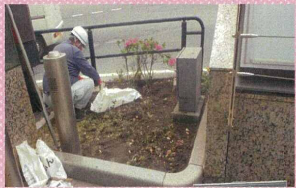
国道54号中区紙屋町(ランヴェールビル前・合人社ビル前)
