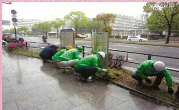
国道54号中区基町（バスセンター前）
