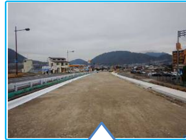
敷均した路盤材の上にアスファルト舗装を行います。
