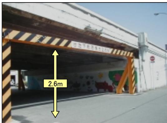
国道31号 呉市三条に呉陸橋があります。その橋桁の下は、昨年3月に両城小学校6年生のみんなが「卒業の思い出」と落書きで汚れていた壁面に自分たちのデザインした両城の町並みなどを書いた場所ですが、こは橋桁が低く、橋下高さ制限を2.6mの標識をだしてはいますが、以前から車の接触と思われるコンクリート橋桁の損傷が絶えないので橋の保護のため防護柵を設置しました。
