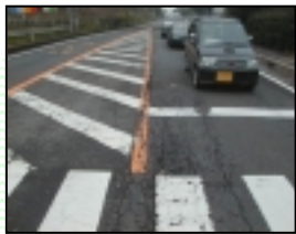
クラックがで、舗装が凸凹になっています。
