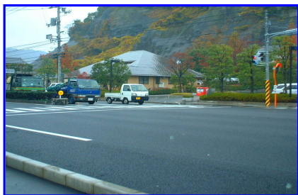
呉市阿賀中央付近（舗装修繕完了）
