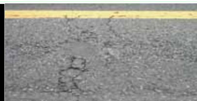
舗装のひび割れ
