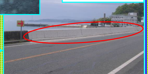
写真②:波返しの壁 設置
