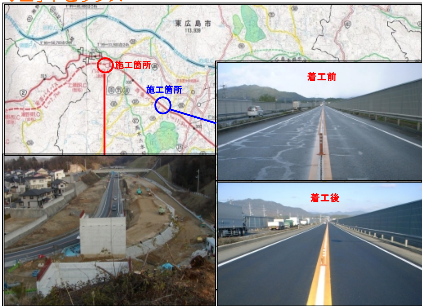
安芸バイパス飯田改良工事
